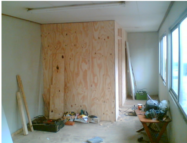
EHBO-ruimte in aanbouw
